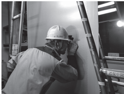
写真2 スケール残り検査状況 Photo 2 Inspection of scale defect
